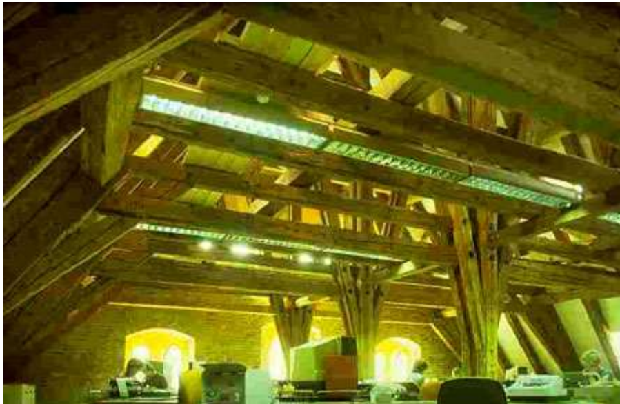
Projekt: Sanierung Sparkasse Straubing
