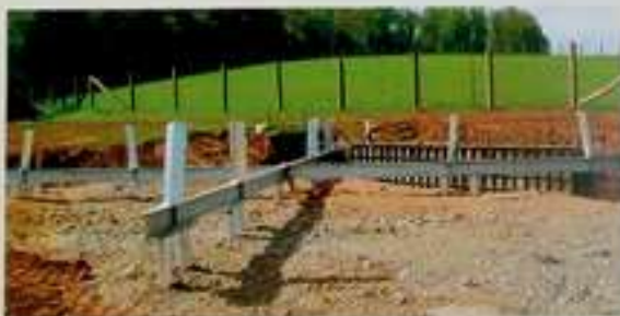
Blick auf die Eisenkonstruktion der Fa. ASS Strassenbau aus Warburg-Scheibler und auf die Stützmauer, gefertigt von der Fa. Eckhoff, Liebenau-Kleinberg
