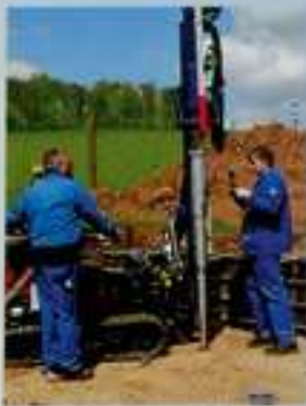
Mitarbeiter der Firma Barmeyer, Paderborn bohren die Erddübel ein
