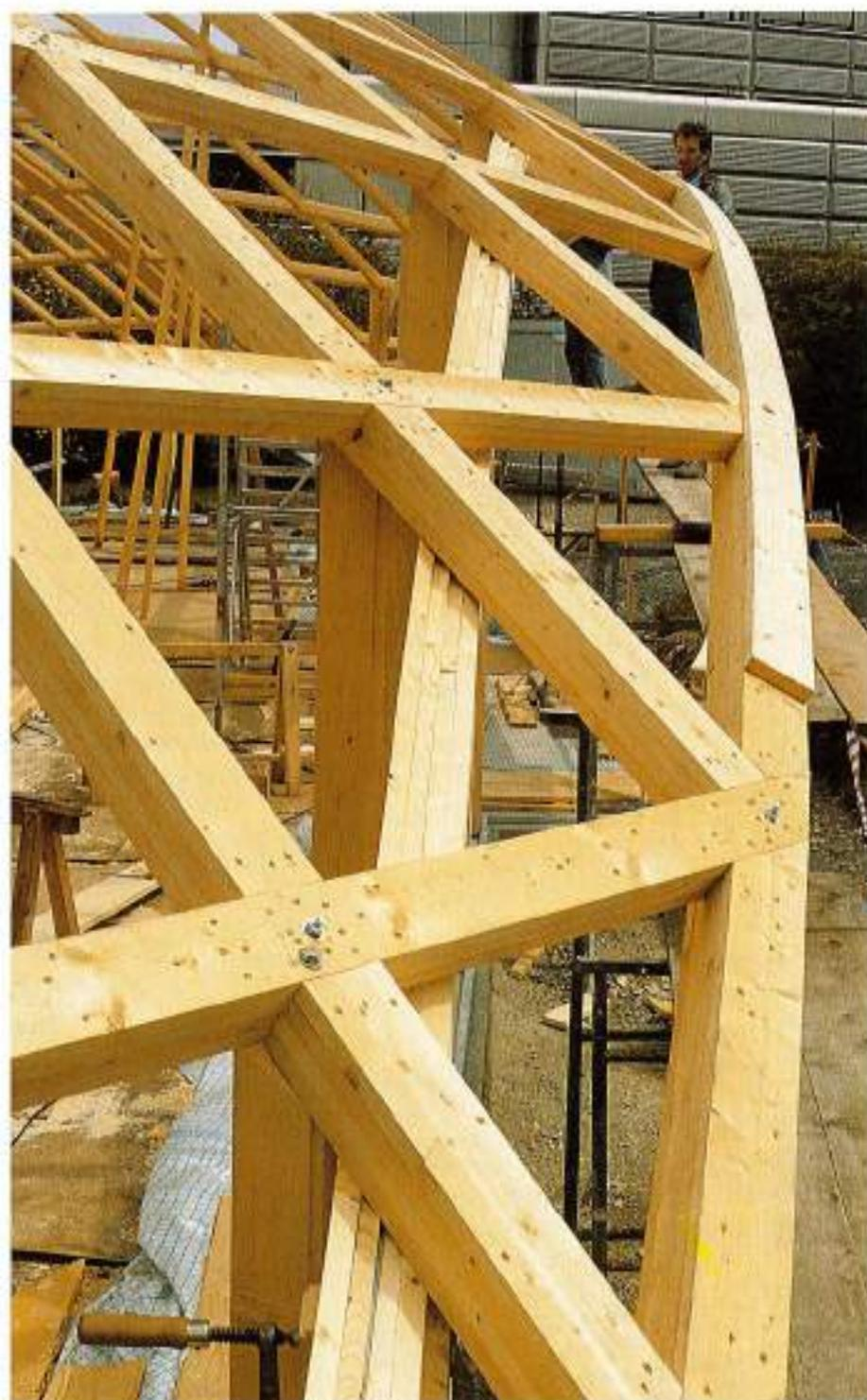
Der Randbalken in den Schnittpunkten der beiden Hauptrichtungen (Abb. 11).
