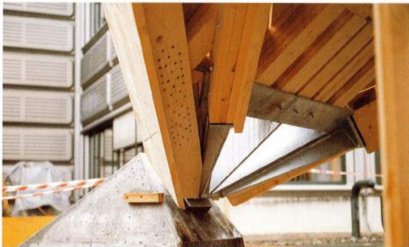
Auflager-Detail in den vier Eckpunkten des Grundrisses (Abb. 8).
